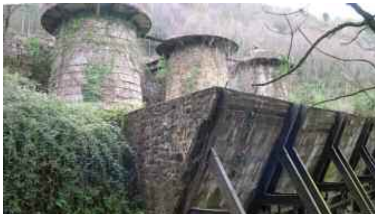
Zerain :Fours de l'ancien complexe minier de Aizpea
